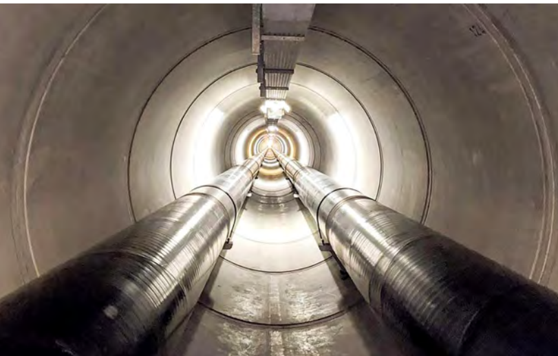
Fernwärme gelangt über heißes Wasser in gut gedämmten ober- und unterirdischen Leitungen zu den Verbrauchern
