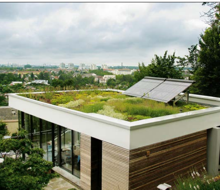
Sinnvolle Kombination: Gründach und Solar-Anlage
