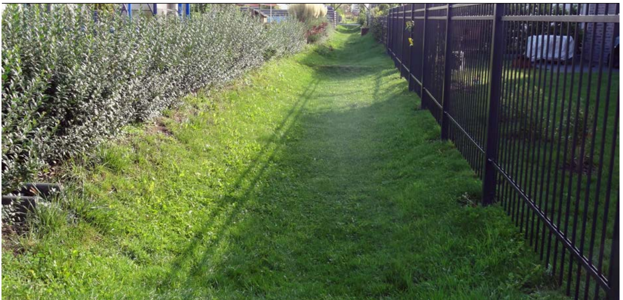
Gemeinsame Versickerungsmulde zwischen Grundstücken
